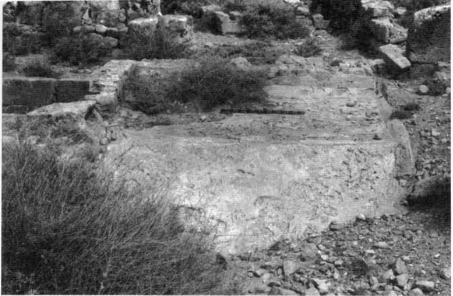
Figure K. Le bâtiment au sud de l'église orientale. 'Piscine' sud, avec fond incliné.
