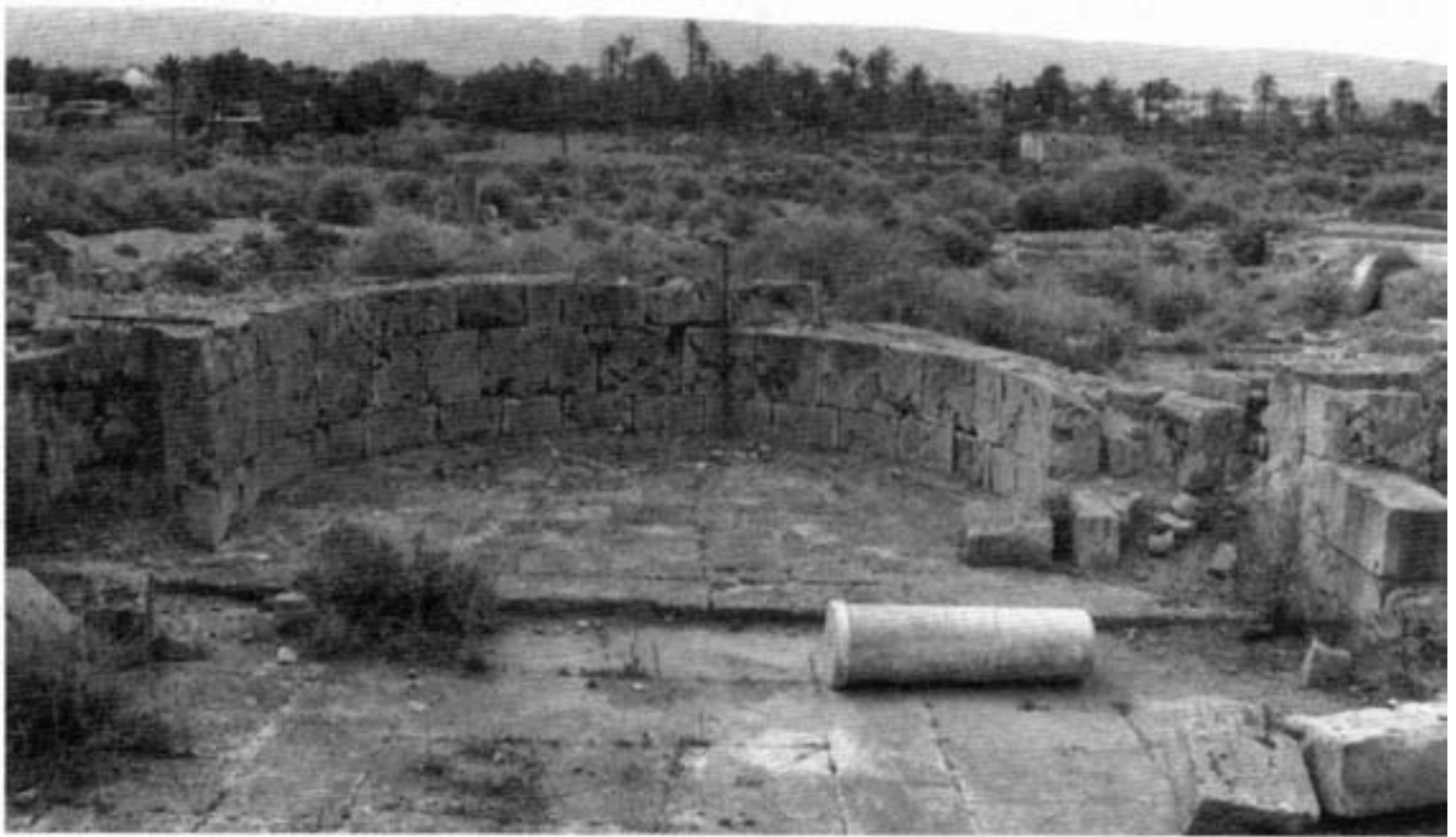
Figure 7. Le bâtiment au sud de l'église orientale. La salle principale avec une abside vers le sud et deux niches latérales, et dallage en plaques de grès.
